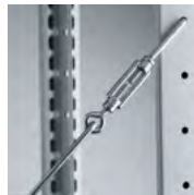
Diagonalstrebe mit Spannschloss
